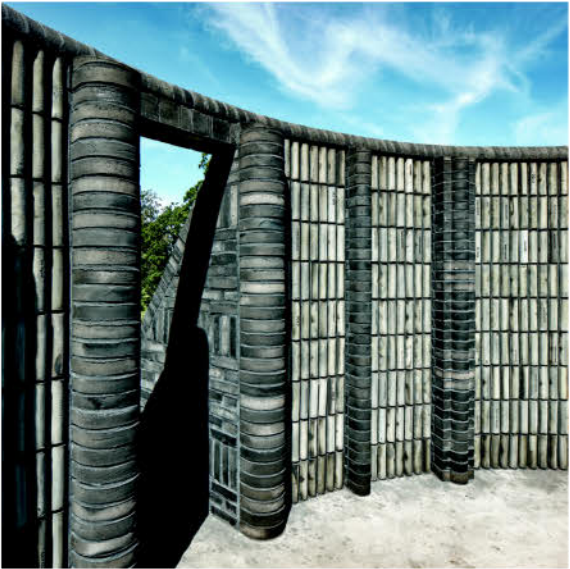
> Ulla Viottis bibliotek, der rejser sig fra en skrånende lysning med højt græs, er udformet som en cylinder i hårdtbrændte, blådæmpede sten, hvis farver changerer fra hvidgrå til sort. Bånd af standerskifter inddeler bygningens ydre i vandrette lag og understreger den cylindriske form.
