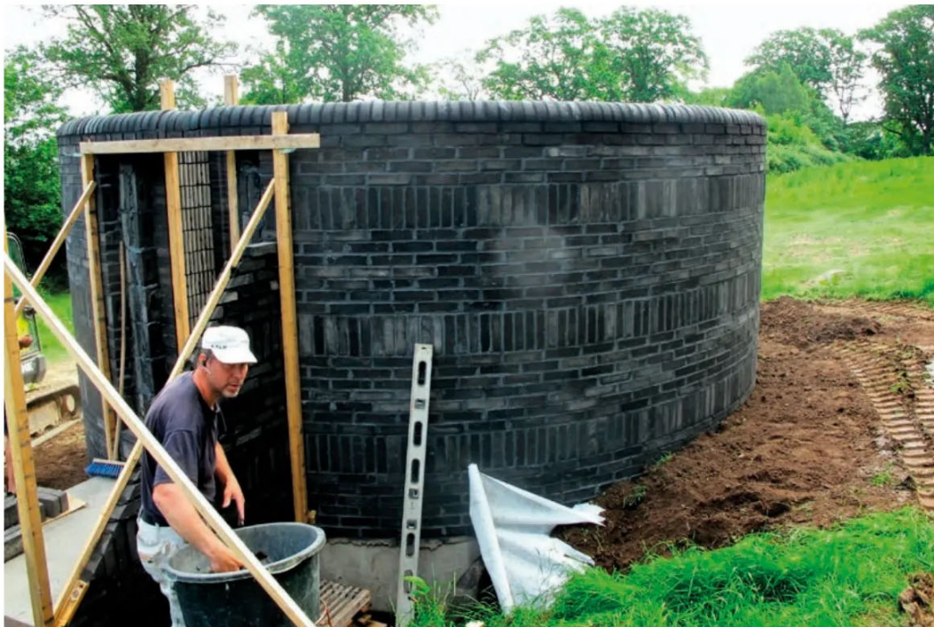
Patrik Wester lägger sista murhanden vid tegelbiblioteket. De snedställda murarna vid ingången.
